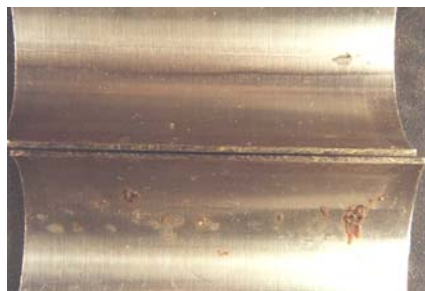
Contaminação superficial com ferro no interior de um tubo provocada por reparo sem cuidados.
